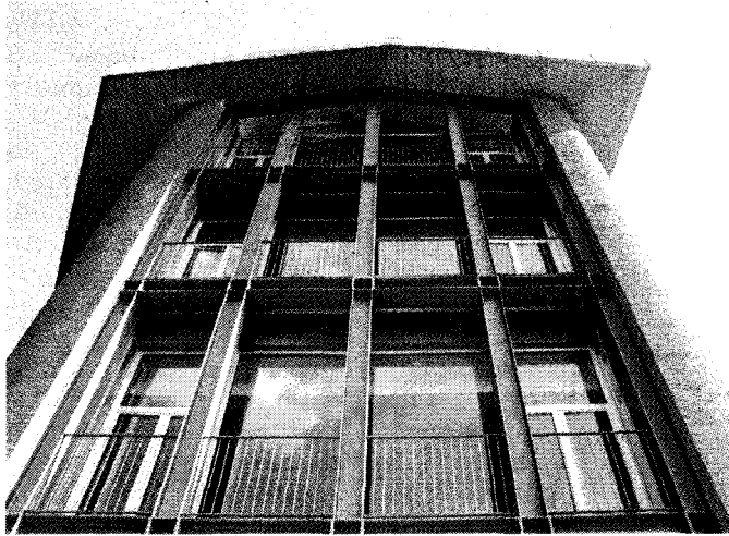
La facciata dell'edificio che ospita la scuola
